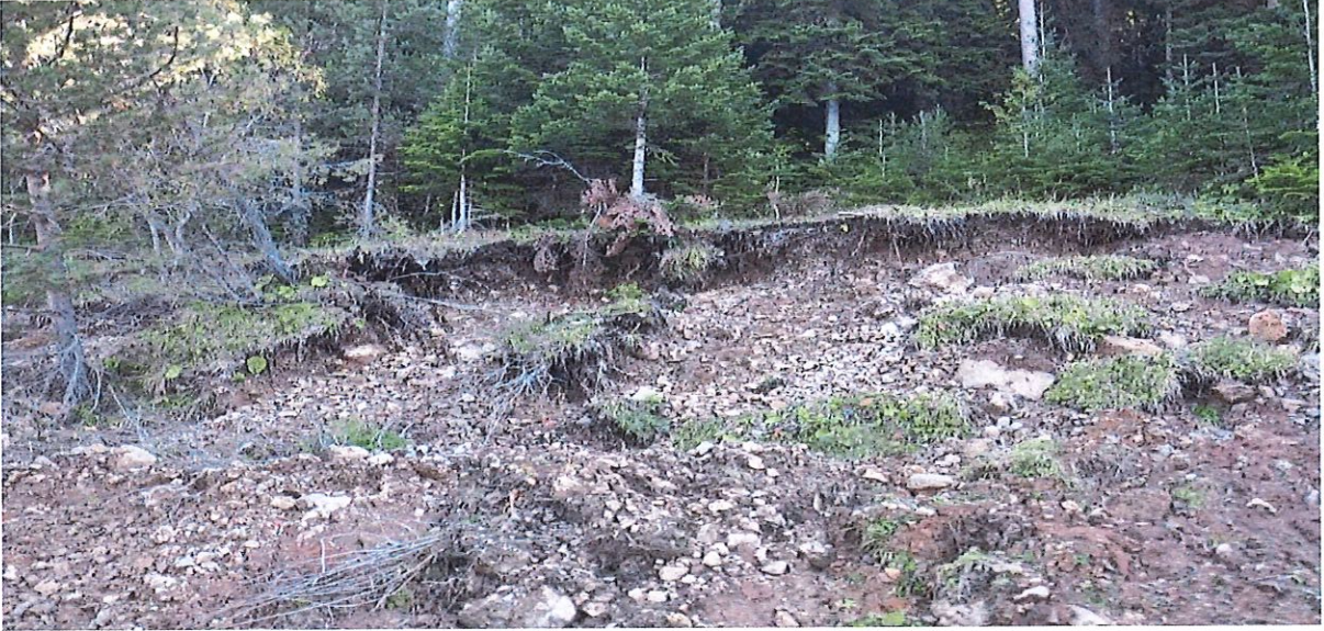
Foto: 5 havzasının üst kesimindeki yol şevlerinde ayrılmış killi kireçtaşı üzerinde oluşan heyelan
