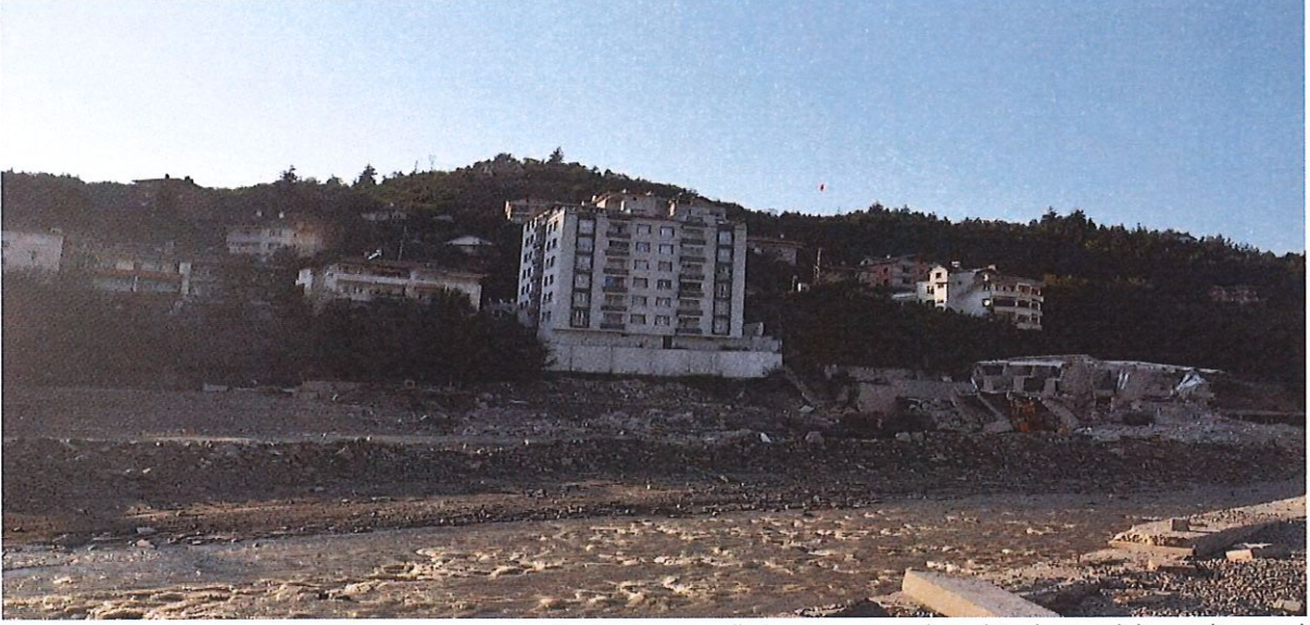
Foto:8 Bozkurt taşkınında 72 can kaybının çoğu, taşkın yatağı kenarına yapılmış binaların yıkılmasıyla meydana gelmiştir. Fotoğraf, yıkılan binaların enkazı taşındıktan sonraki durumu göstermektedir.
