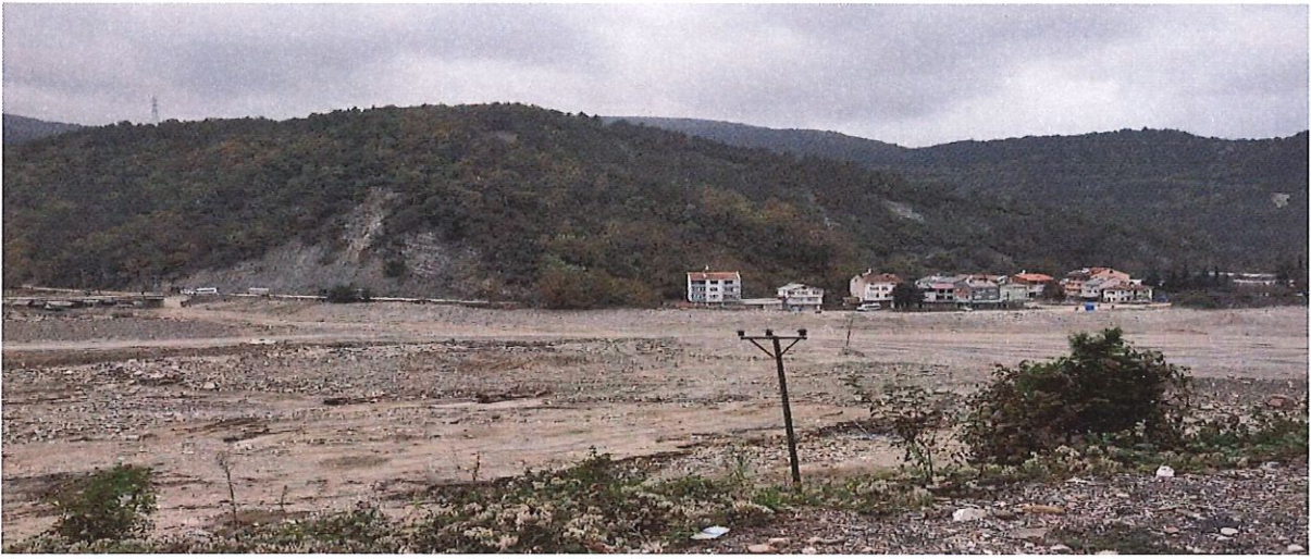
Foto: 11 Ayancık havzasında üç derenin birleştiği eğimin azaldığı yerde taşkın alanına yayılan yerlerde yapılan meskenler yıkılmış ve 17 can kaybının çoğu bu yıkılan meskenlerde meydana gelmiştir.
